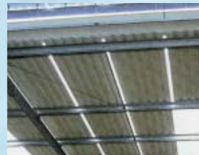
Les fentes permettent la ventilation sur toute la surface de la toiture
